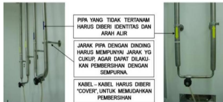
Gambar 8. Desain Pemasangan Pipa
