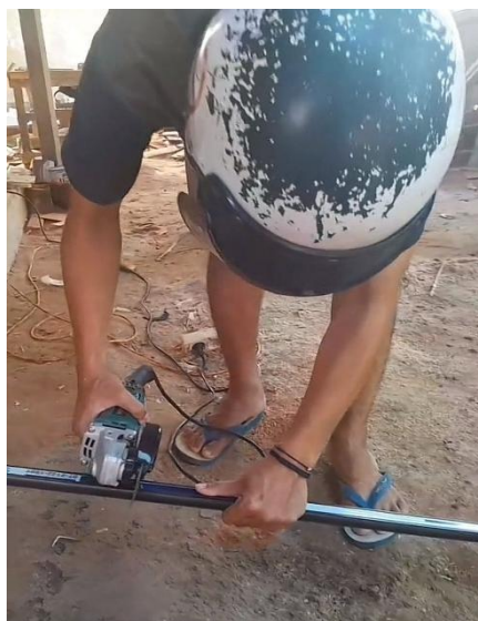
Gambar 4.1 Pembuatan kerangka dasar dan pemasangan roda caster
