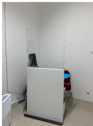
Gambar 3. 1 Gambar Tabir Perisai Radiasi Pada Ruang Mammografi RSUD Bagas Waras Klaten
